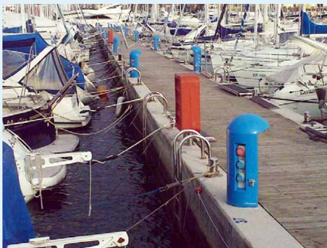
Fotografija 30: Lestve in električne omarice s pitno vodo
