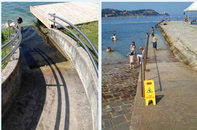
Fotografija 25: Klančina (»rampa«) za dostop v vodo
